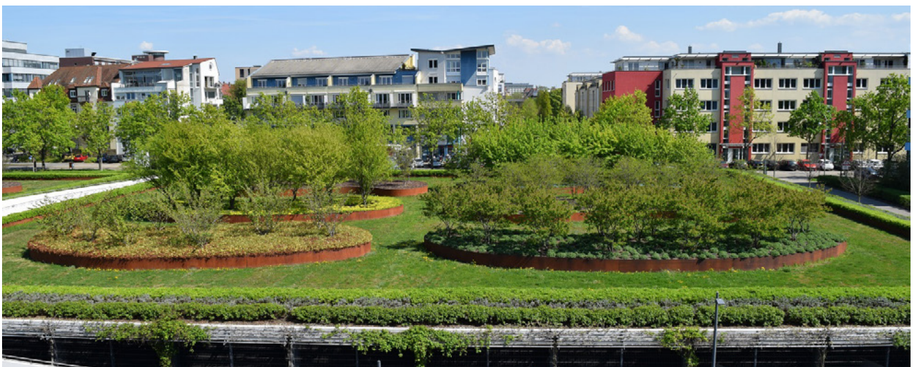
Dachbegrünung Parkhaus, Karlsruhe © Bundesverband Gebäudegrün e. V.
