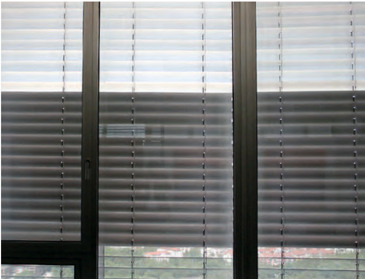
Sonnenschutz mit Tageslichtlenkung oben und Sichtbeziehung nach außen durch Lochung unten
