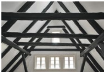
Links: Innendämmung aus Stroh
