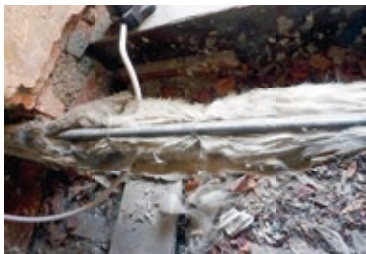
Ungedämmte Rohrleitung
