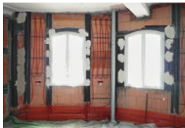
Links: Innendämmung im Bestand
