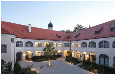
Gold - Private Bauwerke Schloss Geltofung - Aiterhofen
