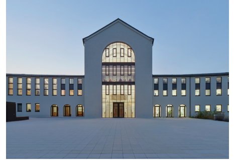
Bronze - Öffentliche Bauwerke Kirche St. Anton - Schweinfurt
