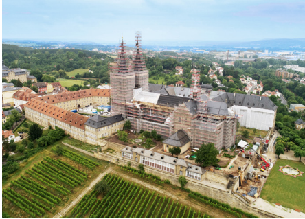
Gold - Öffentliche Bauwerke Ehem. Abteikirche St. Michael - Bamberg
