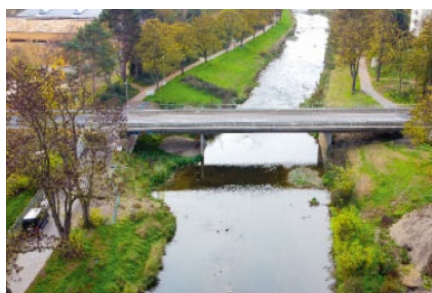
Die Brücke der L83 über die Ahr Bild: Becker Ingenieure GmbH
